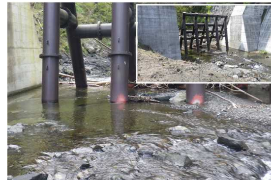
図 富士川水系楮根川での施工事例
