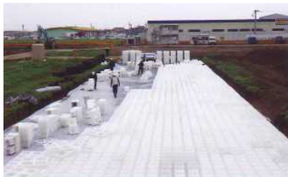
写真 施工の様子
