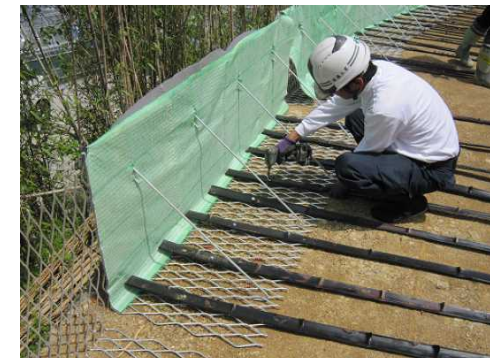
図 バンブーウォールの施工状況
