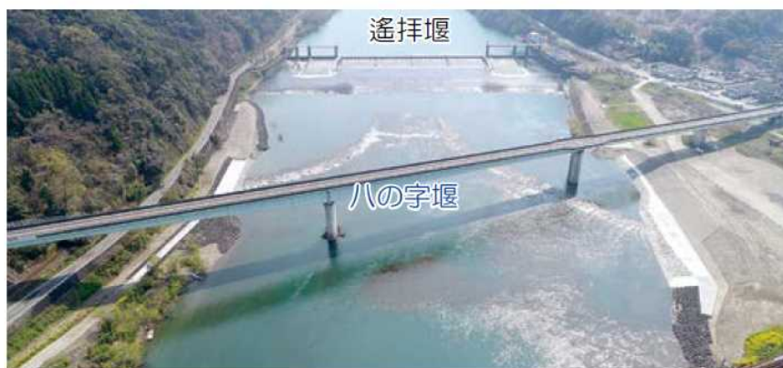
画像 完成した八の字堰
