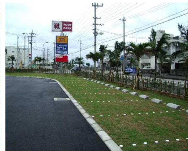
写真 合成樹脂系の緑化舗装
