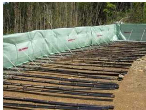
図 バンブーウォールの施工状況
