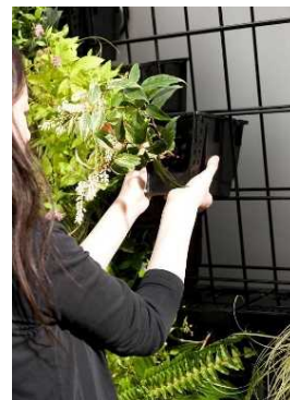
写真 施工の様子
