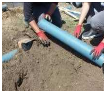
写真 通気透水管の敷設
