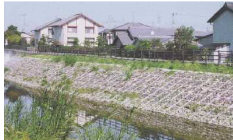
写真 施工イメージ
