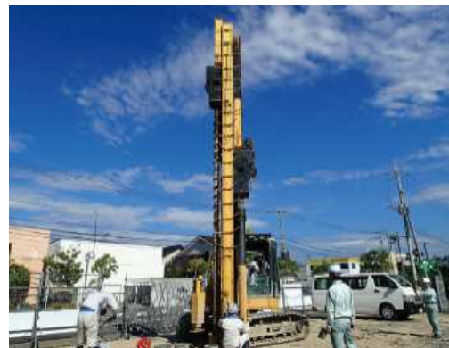
図 佐賀県佐賀市での施工事例
