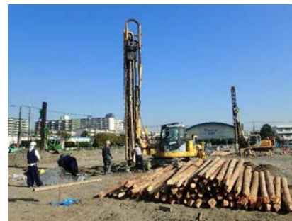
図 LP-LiC工法の施工の様子
