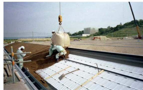
写真 湿性多孔質軽量人工土壌の施工
