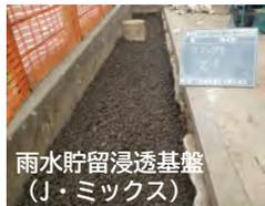
雨水貯留浸透基盤 (J・ミックス)
